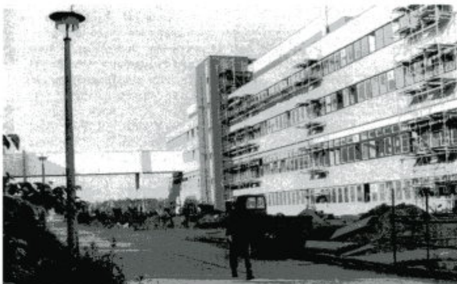
Bauarbeiten für das neue Betriebsgelände „Objekt 2“ auf der Grenzstraße 28
