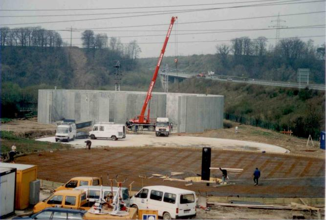
Die Bauarbeiten für die Erweiterung der Kläranlage Goslar gehen zügig voran. Die Erdbauarbeiten für die drei Rundbecken wurden abgeschlossen, die Betonsohle des ersten Belebungsbeckens ist gegossen. Die Betonfertigteile für die Beckenwände werden bereits aufgestellt.
